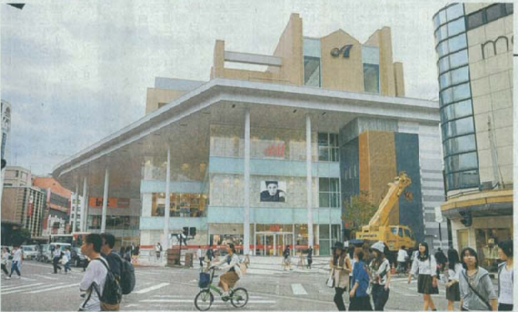
18日に商業フロアが先行開業する「片町きらら」＝金沢市片町2丁目
